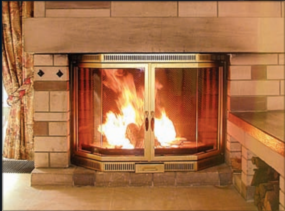
Nachher: neuer Glanz nach Einbau einer sicheren Spartherm-Kaminkassette
