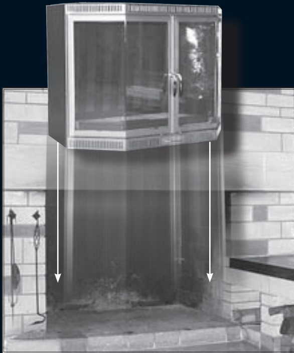
„Eine offene, alte und nicht ungefährliche Feuerstelle.“
