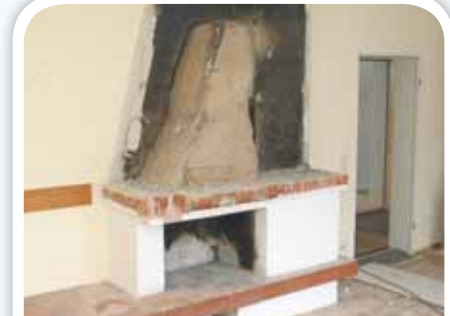
Abbruch des Offenen Kamins mit Rauchfangzug.
