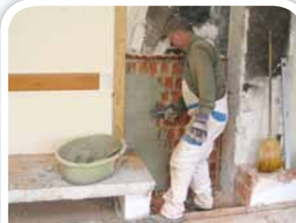
Verputzen der rohen Ziegelmauer nach beendetem Rückbau.
