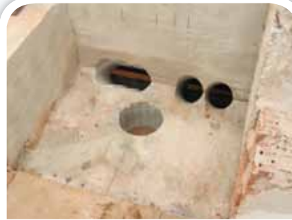
Kernbohrungen durch die Kellerdecke für den separaten Verbrennungsanschluss und die Vor- und Rücklaufleitungen.
